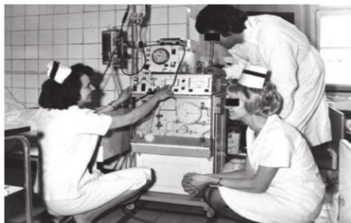
Rycina 6. Instruktaż obsługi sztucznej nerki firmy Bellco 714 z dializatorem zwojowym Vita 2.
